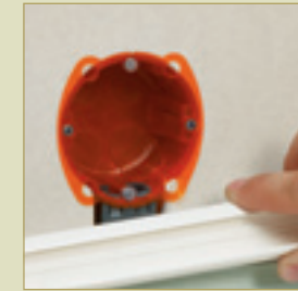
Vérification du positionnement de la boîte et de la moulure
