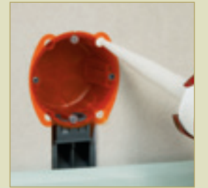
Fixation par étriers et/ou scellement par colle
