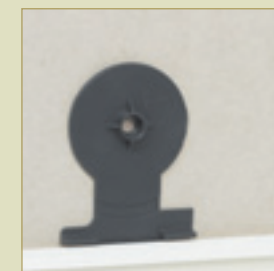
Préparation du positionnement de la boîte avec le gabarit
