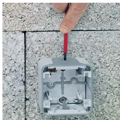
Durchstoßen der Membraneinführung mittels Schraubendreher
