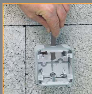
Kabel einführen
