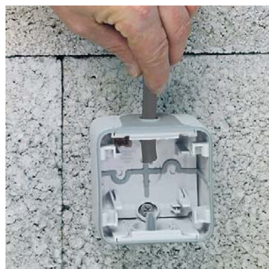
Kabel einführen
