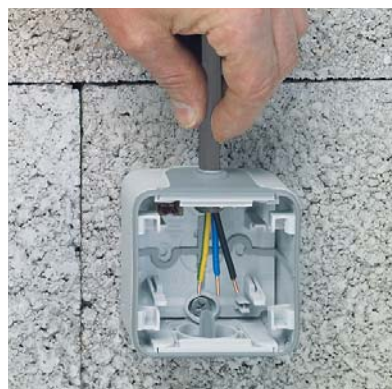
Zum Erreichen der Schutzart IP55 Kabel leicht zurückziehen
