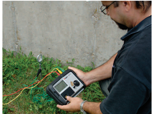
使用DET3TC进行典型的电势降测试法接地电阻测试
